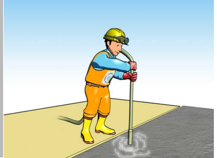
Resim 8: Vibrasyon uygulamasında kullanılan vibratör tipi beton tabaka kalınlığına göre seçilmelidir.
