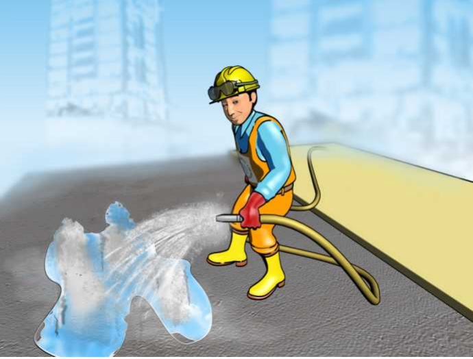
Resim 11: Beton yüzeyinin hortumla sulanması
