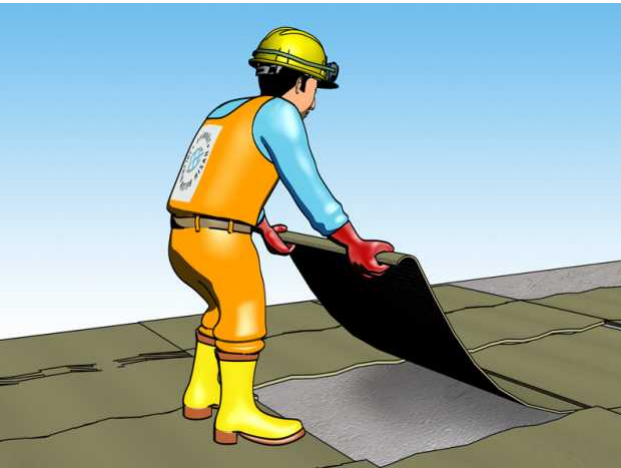
Resim 13: Beton yüzeyine telis bezi serilmesi
