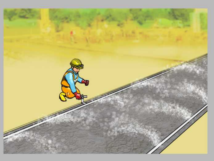
Resim12: Betonyüzeyindepüskürtme sis. oluşturulması
