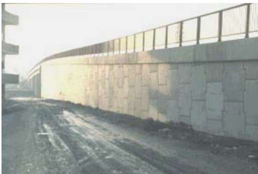
Şekil 13. Arifiye Köprüsü yaklaşım RE-Duvarları, Adapazarı
