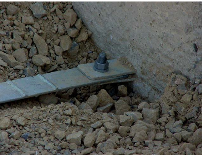
Şekil 10. Çelik şerit bağlantı Detayı (REAS, 2006)
